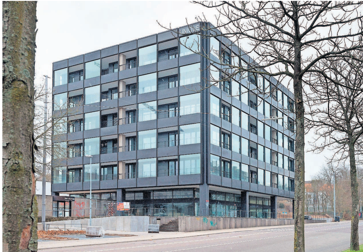
Gerade sind die ersten Mieter eingezogen in das denkmalgeschützte frühere Siemens-Haus. FOTO: IRIS MAURER
